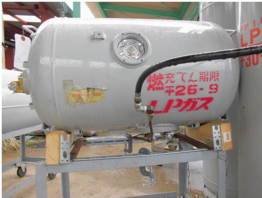
写真2 メインバルブよりガス抜き
