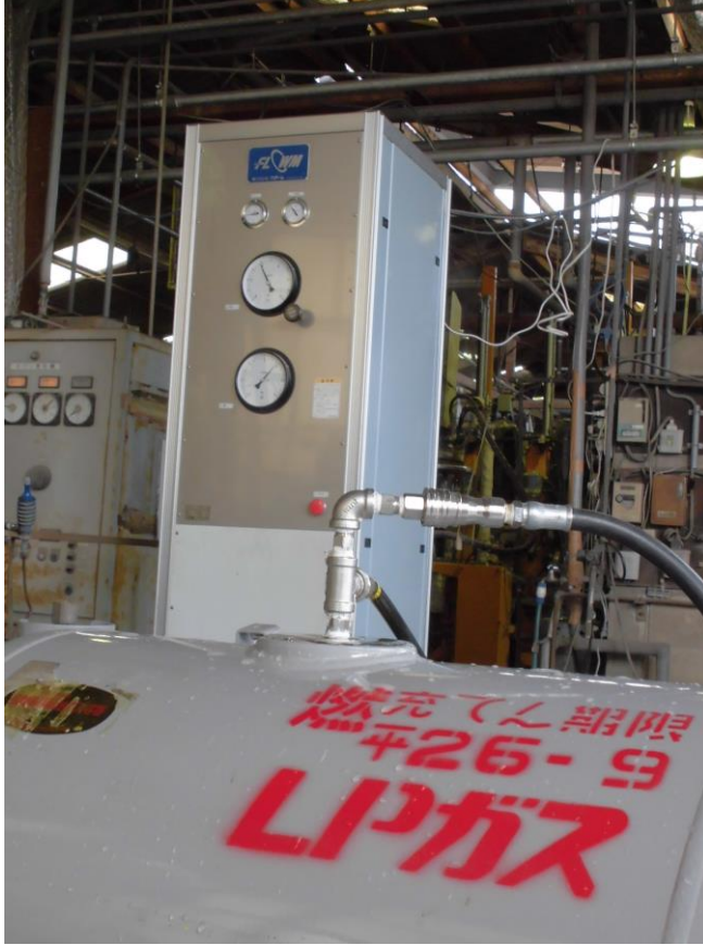
写真4 非水槽式で 3.8MPa に加圧し耐圧試験
