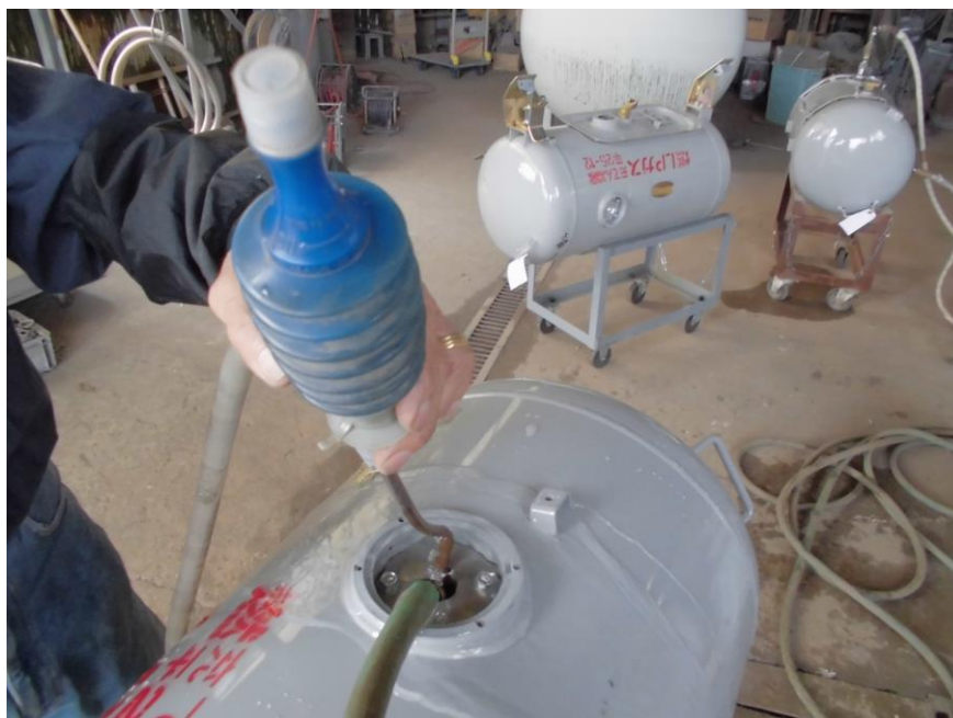
写真3 注水後のエア抜き作業
